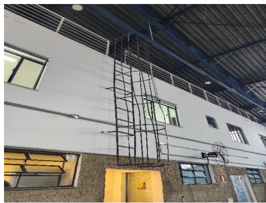
Foto 02: Estrutura danificada da escada atual.
