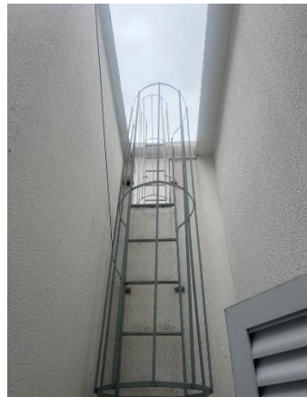
Fotos 04 e 05: Escada marinheiro a ser substituída.
