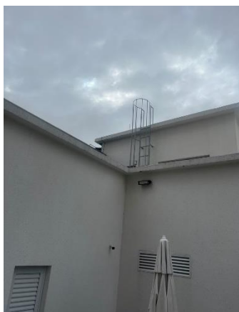
Fotos 04 e 05: Escada marinheiro a ser substituída.
