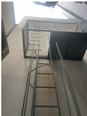
Fotos 04 e 05: Escada marinheiro a ser substituída.
