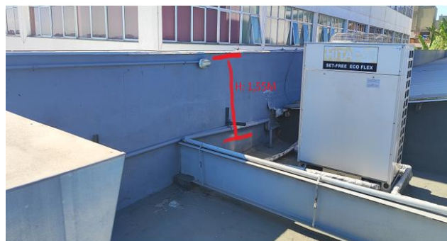
Foto 10: Local de instalação da escada de marinheiro para descida do telhado
