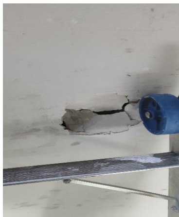
Foto 04: Gesso da parede danificado devido ao apoio da escada.
